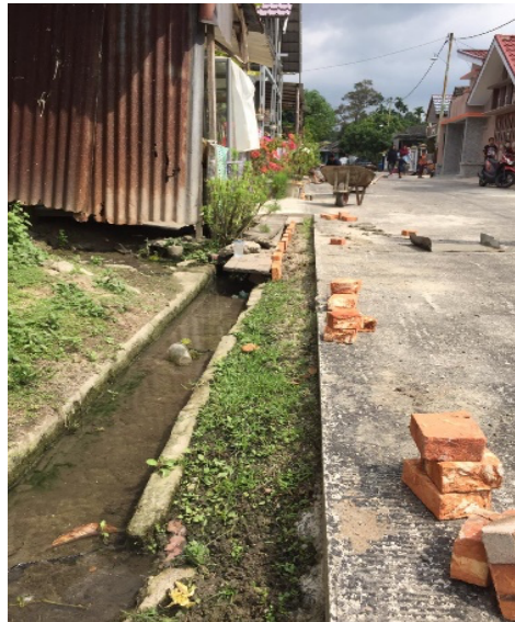
Gambar 1. Kondisi Jalan Sebelum Pelebaran
